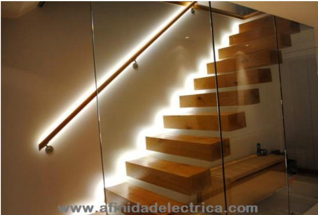
Otra aplicación típica y con la que se obtienen bellos efectos decorativos es la instalación de tiras de LEDs en gargantas, molduras y cavidades en techos y paredes.
